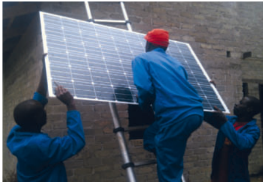
Die Solar-Panels werden auf das Arbeiterhaus montiert.
