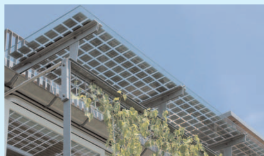
Gebäudeintegrierte Solarstromanlage in Subigen (CH), Jahresertrag 1.000 kWh, Verbundsicherheitsglas für Überkopfanwendungen.
