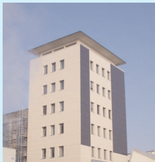
Keramikfassaden-Integration in Pfaffenhofen (D), Jahresertrag inkl. einer ebenfalls installierten MegaSlate® Indachanlage 32.800 kWh.
