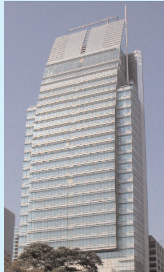
Vollintegriertes Fassadensystem als Sonnen- und Windschutz für Tennisplätze auf dem Dach des One Peking Tower in Hong Kong. Verwendet wurden silberfarbene Apex-Solarzellen in transparenten Doppelglasmodulen.
